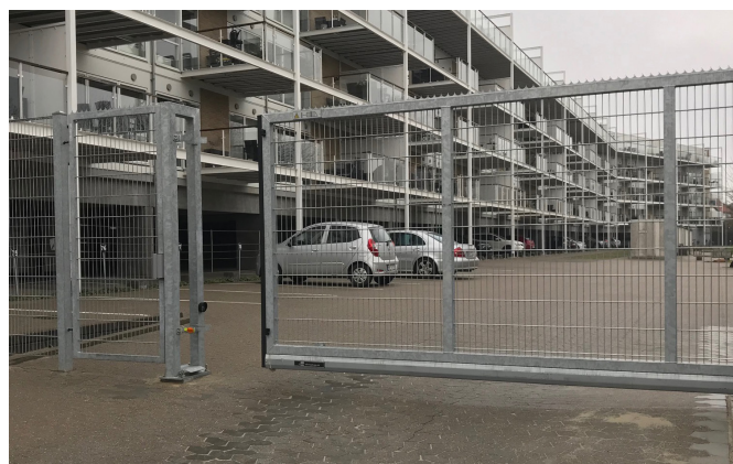
Automatiseret skydeport med nem adgang for beboere
